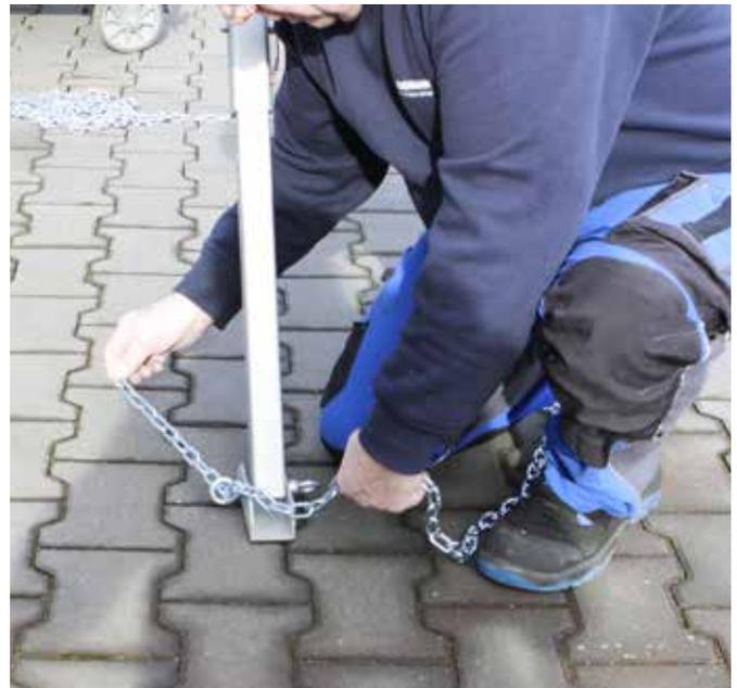
Abb. 17 + 18: Sicherungskette durch die ÖÙe am 2. Fuß fädeln und bis zum 3. Fuß weiter durchziehen.
