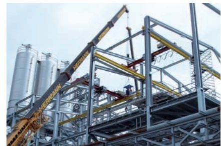
Fertigung und Montage von Brückenlaufkränen
