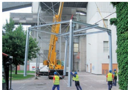
Fertigung und Montage eines Stahlportales
