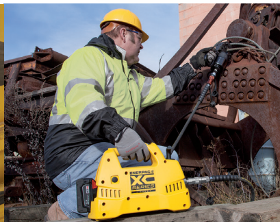
Einsatz mit einem Schneidgerät
