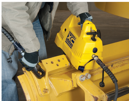
Einsatz mit einem Mutternsprenger
